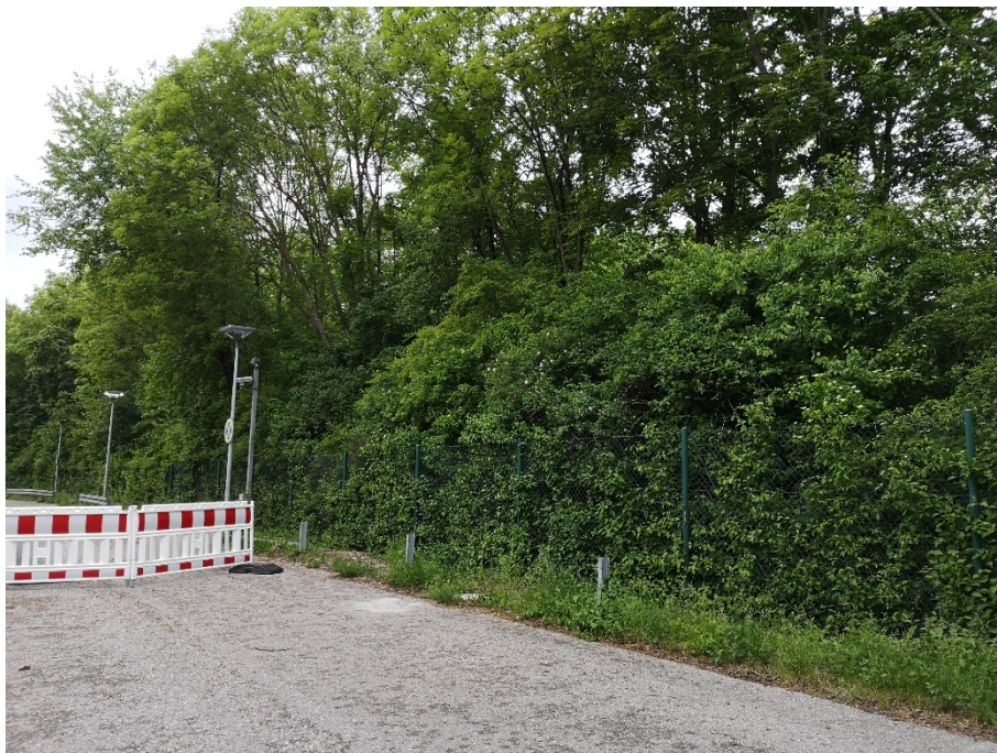
Abbildung 3: Blick von Südost auf den Wall mit Gehölzbestand
